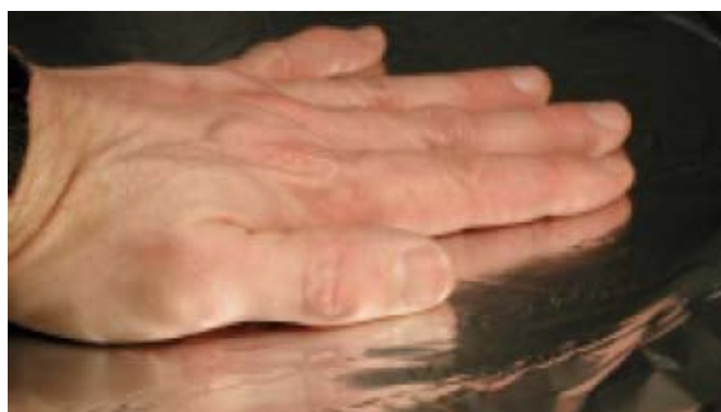
Lisciate accuratamente il foglio, rimuovendo tutte le grinze e le bolle.
