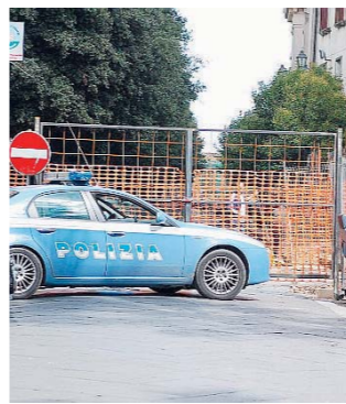
Lavori su Corso Umberto I
