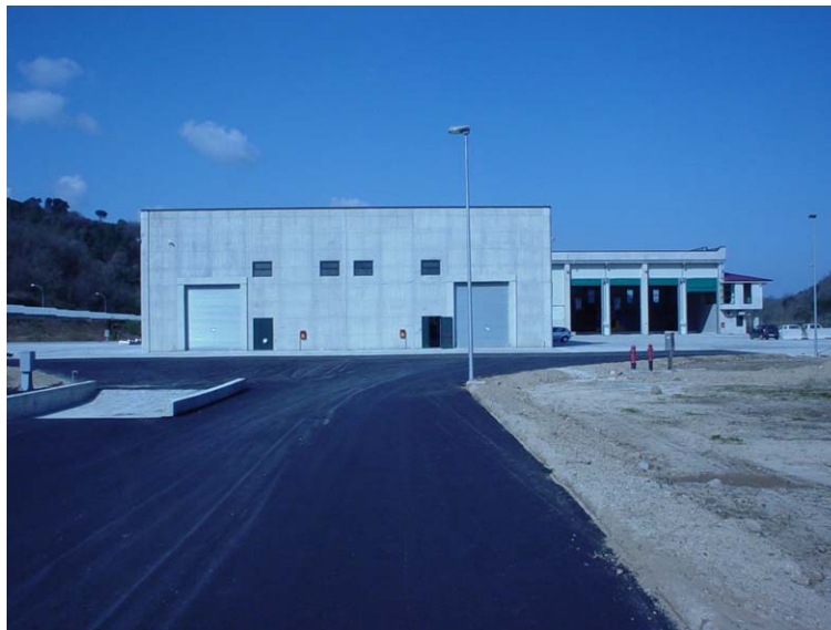
Foto n. 6 – Un esempio di realizzazione impiantistica con HEBIOT ®
