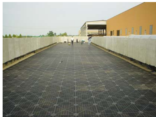
Foto n. 5 – Pavimentazione aerata
