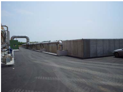
Foto n.2 - Collettore del biofiltro
