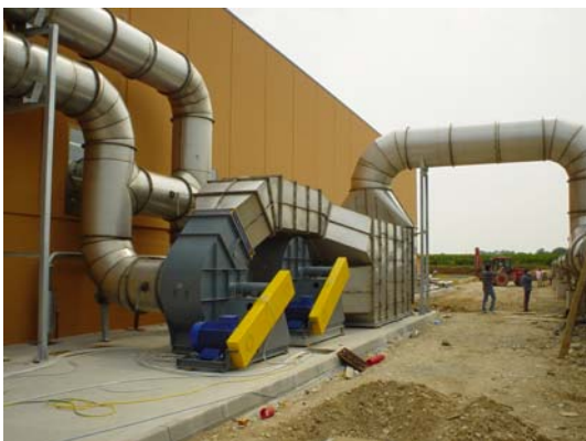
Foto n. 4 – Ventilatore biofiltro
