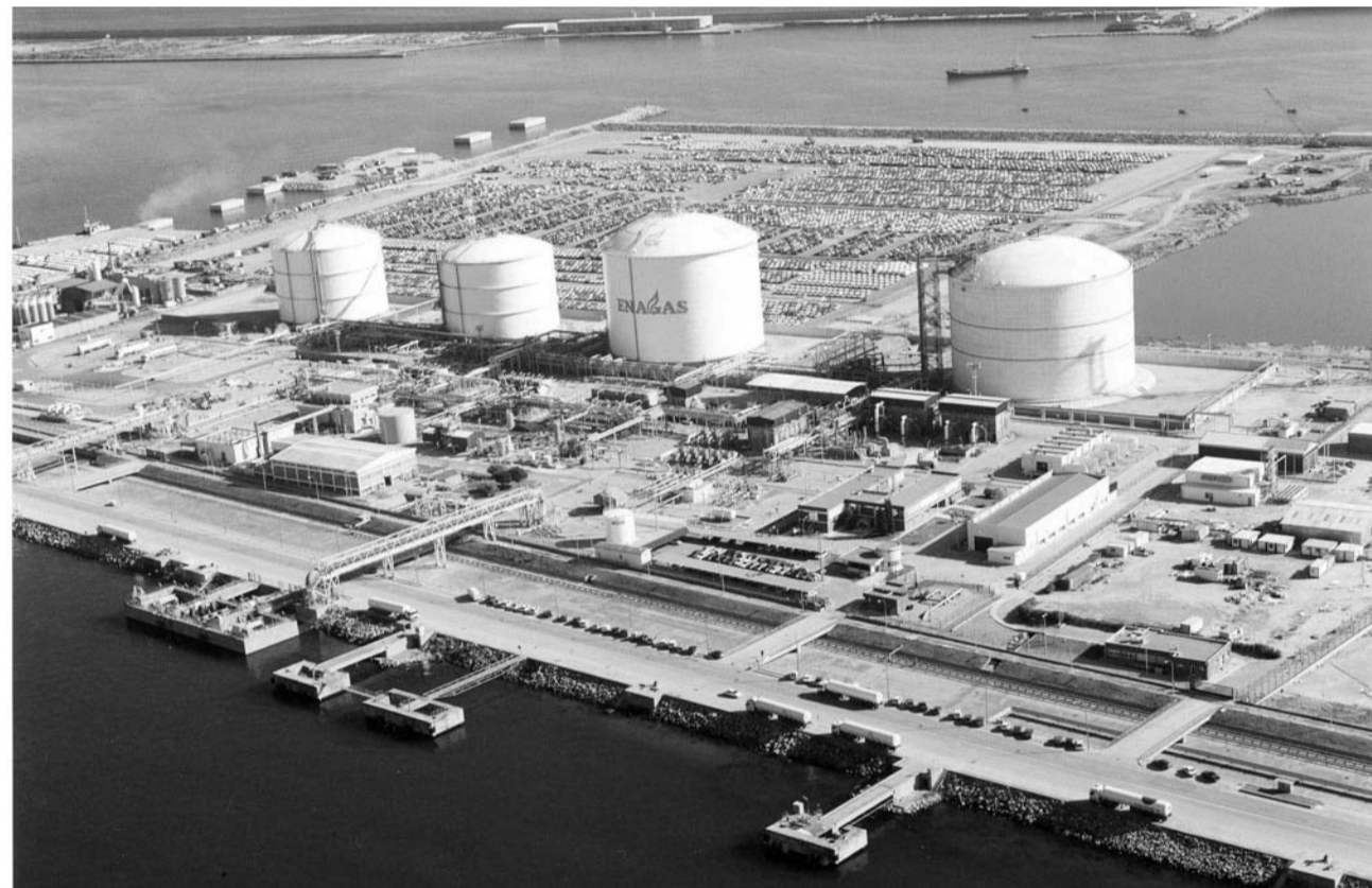
Una veduta dall'alto del rigassificatore di Barcellona. È il più grande impianto della Spagna, che di rigassificatori ora ne ha cinque
