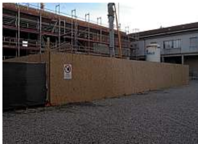
Il cantiere delle scuole elementari a Povegliano FOTO PECORA
